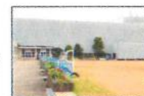
【令和2年 校舎改修中期】
